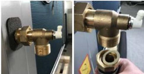
Die angeschlossenen Schläuche und die Winkelverschraubungen sind zu isolieren.
