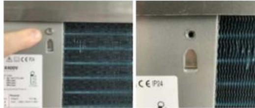
Die Abdeckung kann nun, nach dem Anschluss und entlüften des Vor- und des Rücklaufes, montiert werden. Dazu muss diese links in die Abdeckung des Maschinenraumes und oben in den Deckel der Maschine eingehängt werden.
