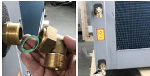
Nach der Montage der Winkelverschraubungen kann das ANSI-Anschlusset angeschlossen werden.
