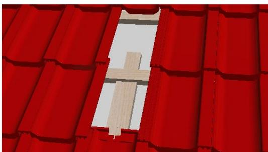
Montieren Sie nun die Ziegelhakenauflage  $80 \times 270 \times 30 \text{ mm}$  und befestigen Sie diese mit zwei Schrauben  $5 \times 60 \text{ mm}$ .
